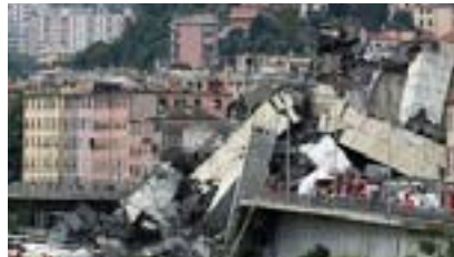
14-08-2018 Derrumbament del pont Morandi a Génova
